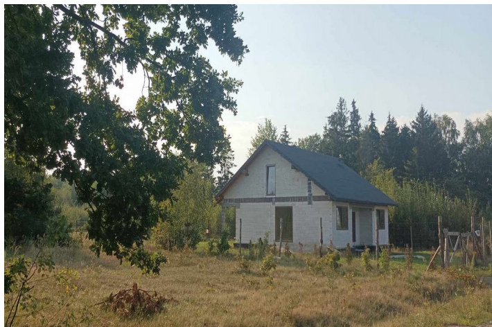
Fot.2. Obiekt w trakcie budowy w ciągu ul. Spacerowej
