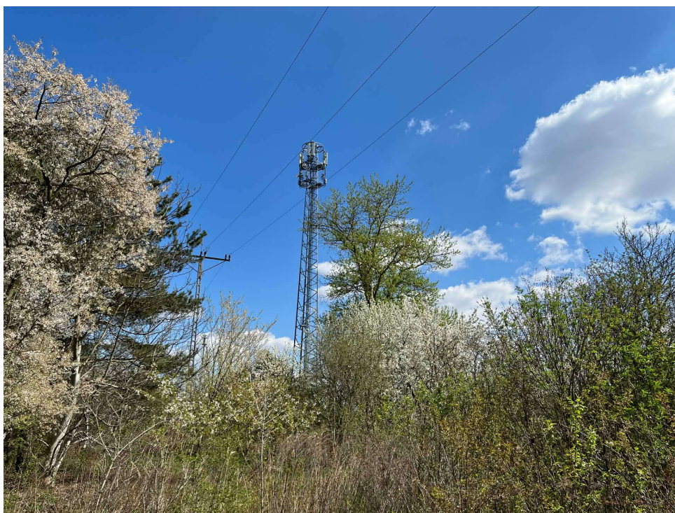
Fot.9. Widok na maszt telefonii komórkowej i linię energetyczną 15kV (kwiecień 2026).
