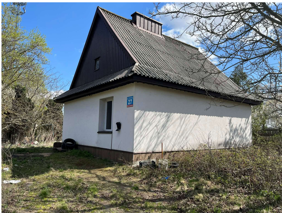
Fot.6. Widok na budynek mieszkalny od południowej strony poza granicami opracowania (kwiecień 2026).
